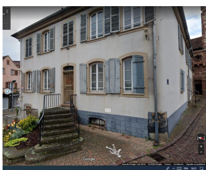
Fig. 2 Ancien notariat 6, place du Général Leclerc
