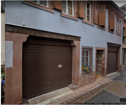
14, cour du Château Grange Provot transformée en logement.
